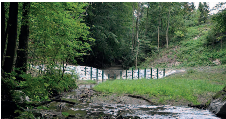
Hochwasserschutz Hagenbach: Wildholzrechen und Regulierung des Flußbettes
