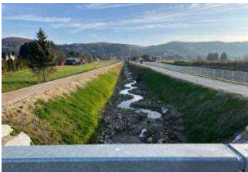
zweiter HW Bauabschnitt von ÖBB Brücke bis Lehnergasse
