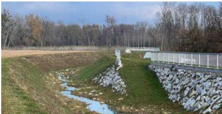
erster HW Bauabschnitt Au bis ÖBB Brücke
